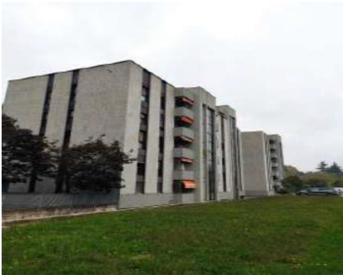
Vista esterna del complesso
