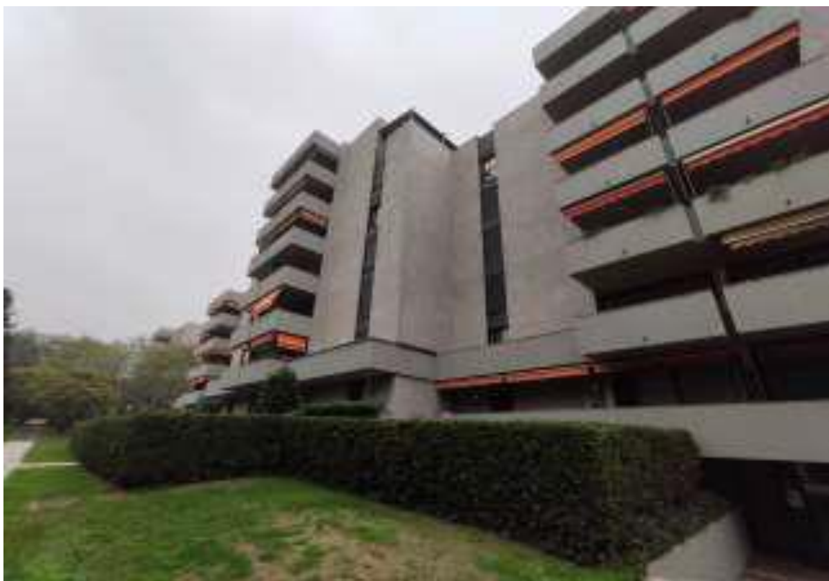
Vista esterna del complesso
