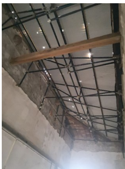
Figure 27 e 28: Particolare della copertura parzialmente crollata (sx) e vista di uno degli ambienti (dx)
