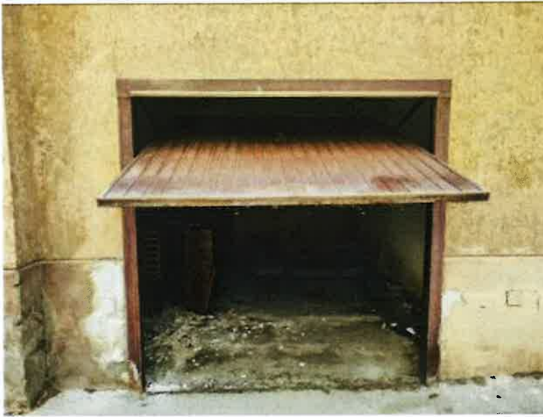
Ingresso su strada privata, box auto sub. 26
