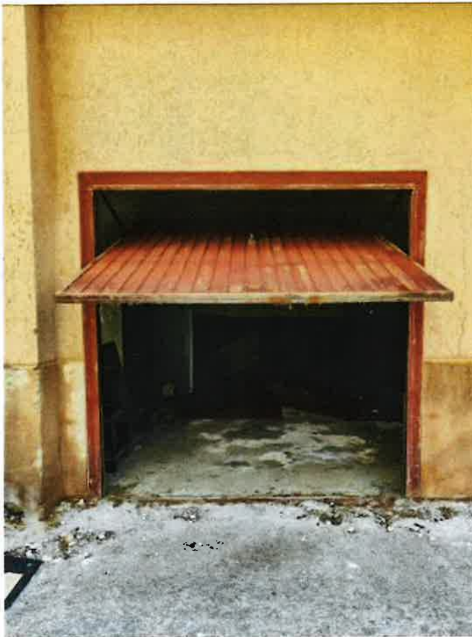
Ingresso su strada privata, box auto sub. 9
