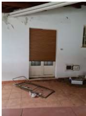
9. Foto esterno fronte e pavimentazione della corte fornite dall'Amministrazione richiedente datate 09/12/2020
