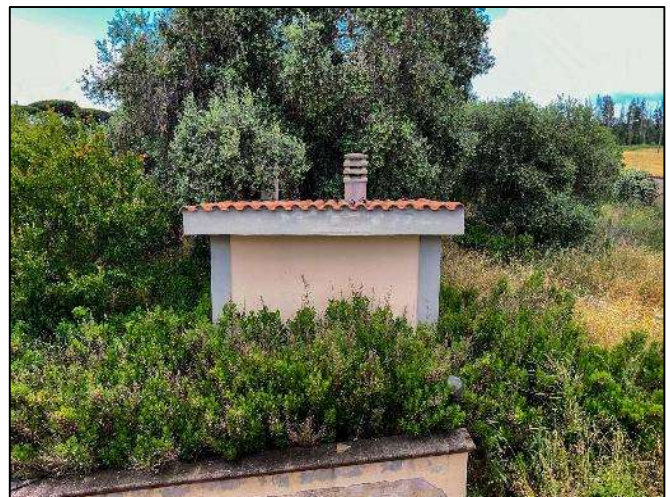
Magazzino in via dell'Agricoltura n. 5
