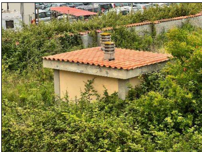
Magazzino in via dell'Agricoltura n. 3
