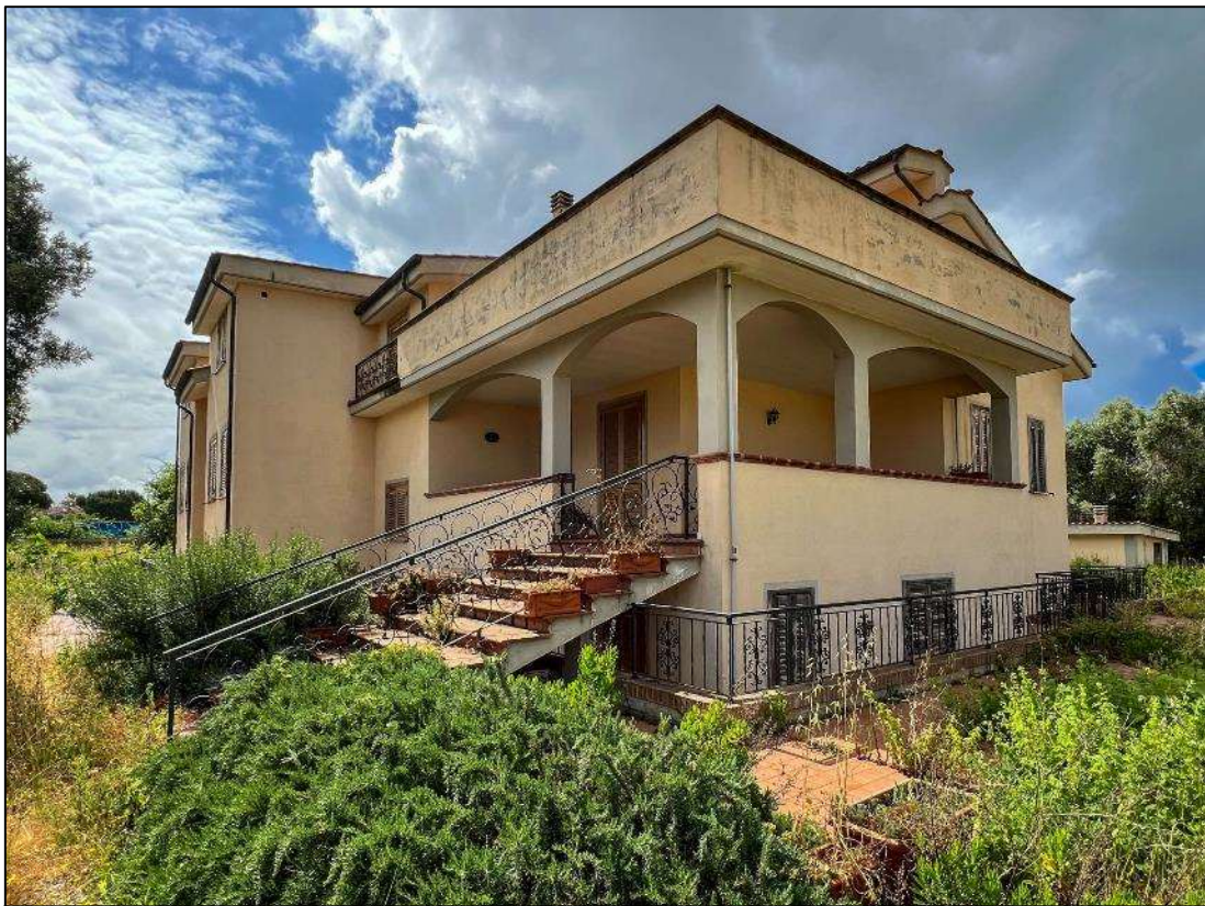
Prospetti anteriore e laterale dell'immobile in via dell'Agricoltura 5 (Interno 2)
