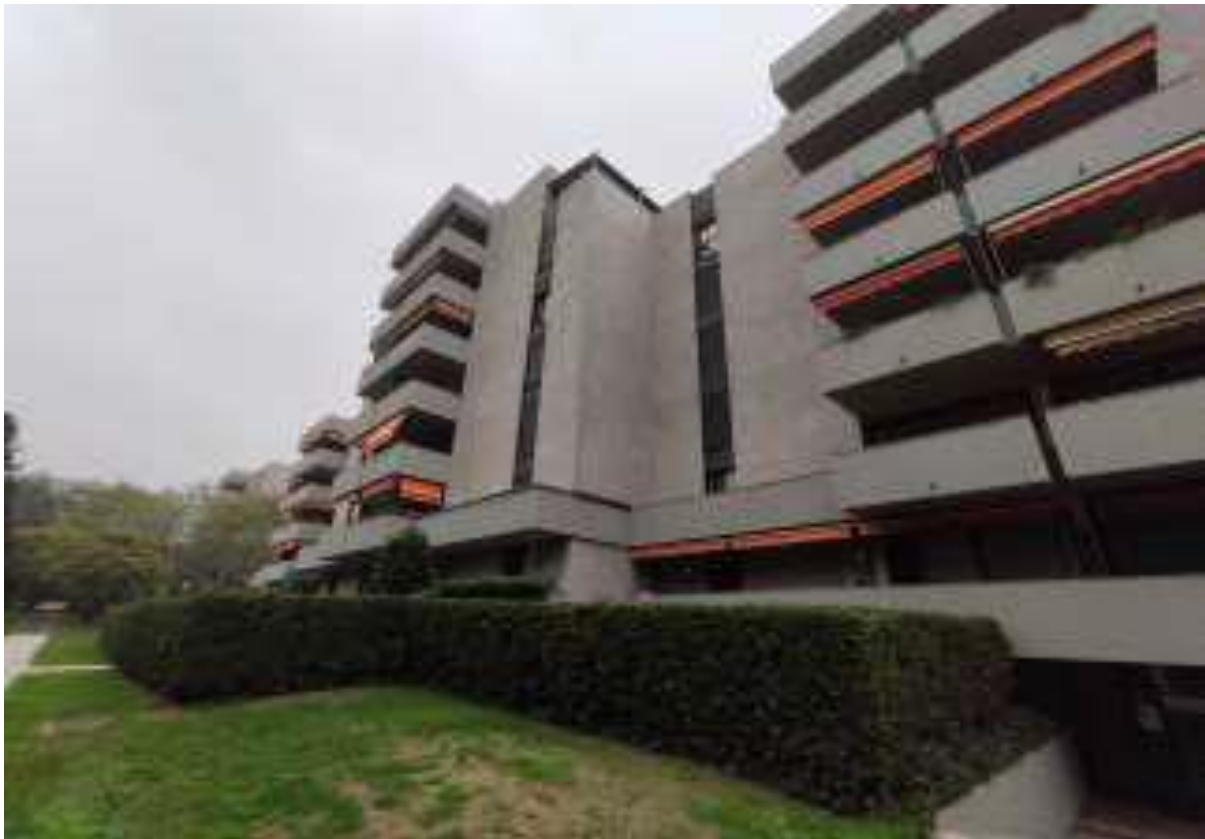
Vista esterna del complesso
