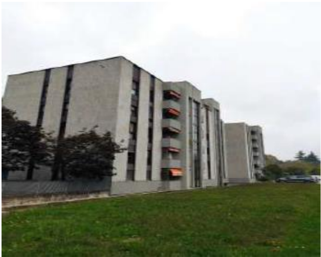
Vista esterna del complesso
