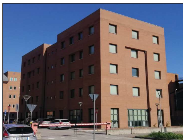
FOTO N° 5 Particolare dell'edificio lato sud
