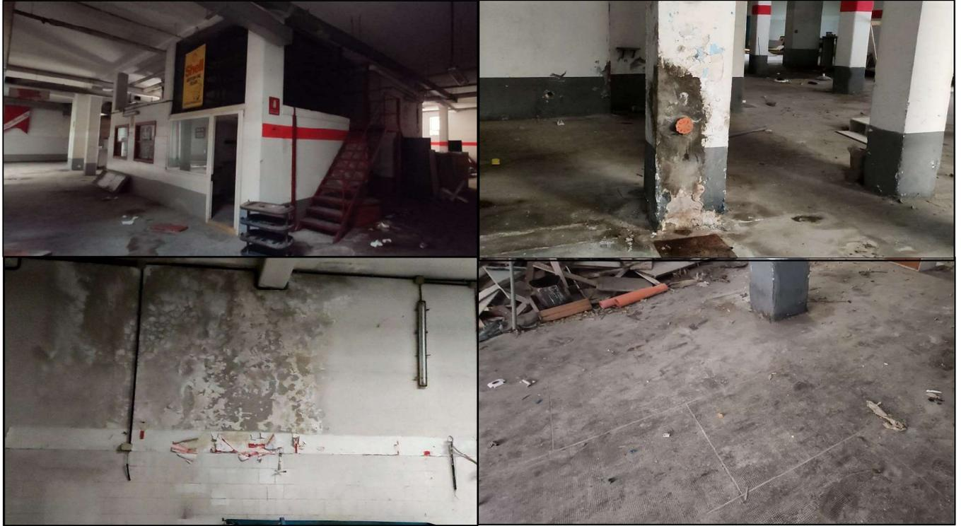
Locali interni - Lesioni strutturali da infiltrazione - Particolare della pavimentazione.
