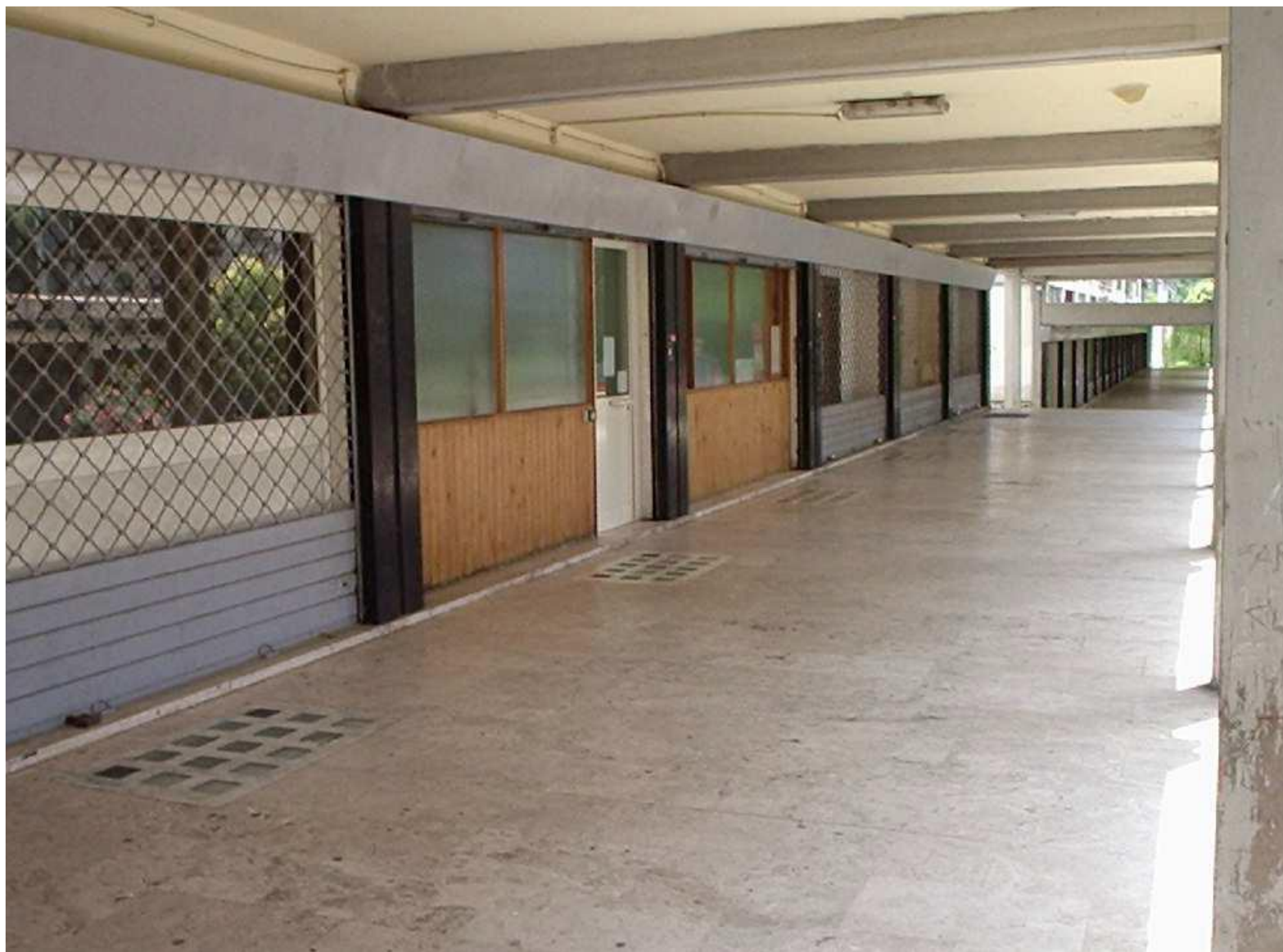
VISTA GALLERIA INTERNA VIA GABRIO CASATI 75
