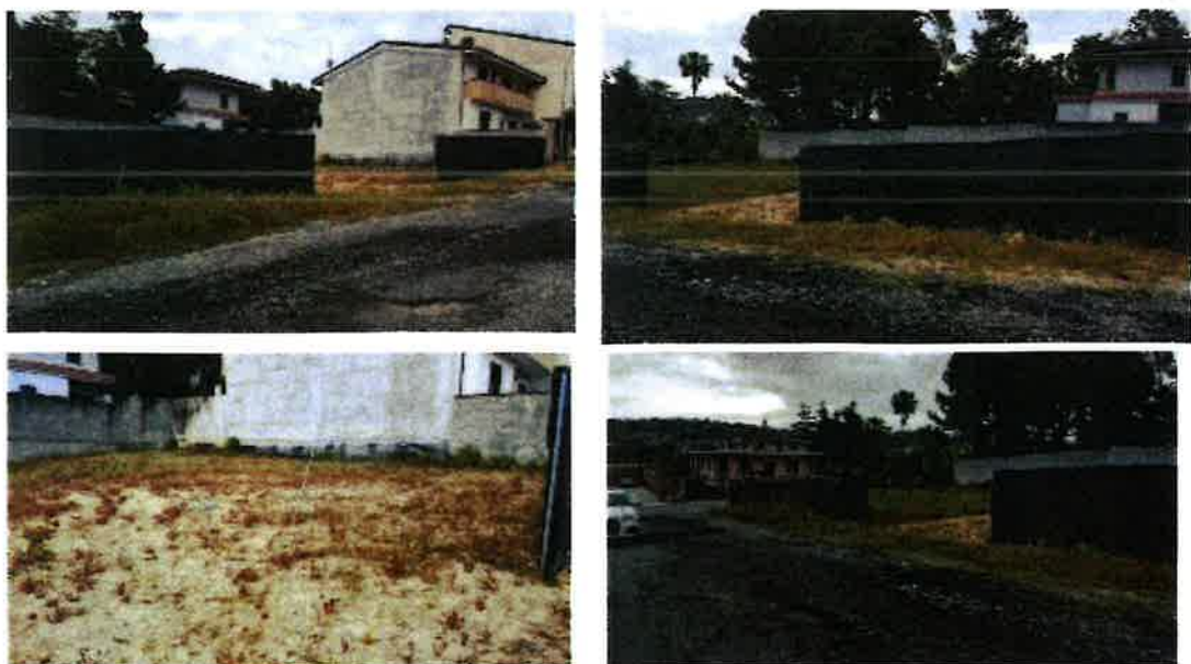
5. Vista della stradella interpodereale d'accesso, della recinzione con rete metallica del terreno in oggetto
