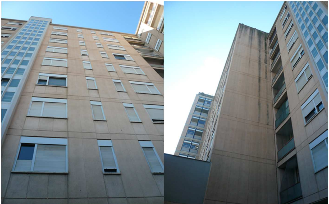
Stato di fatto al sopralluogo
