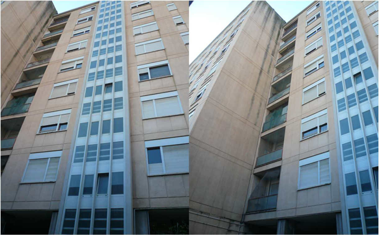
Stato di fatto al sopralluogo
