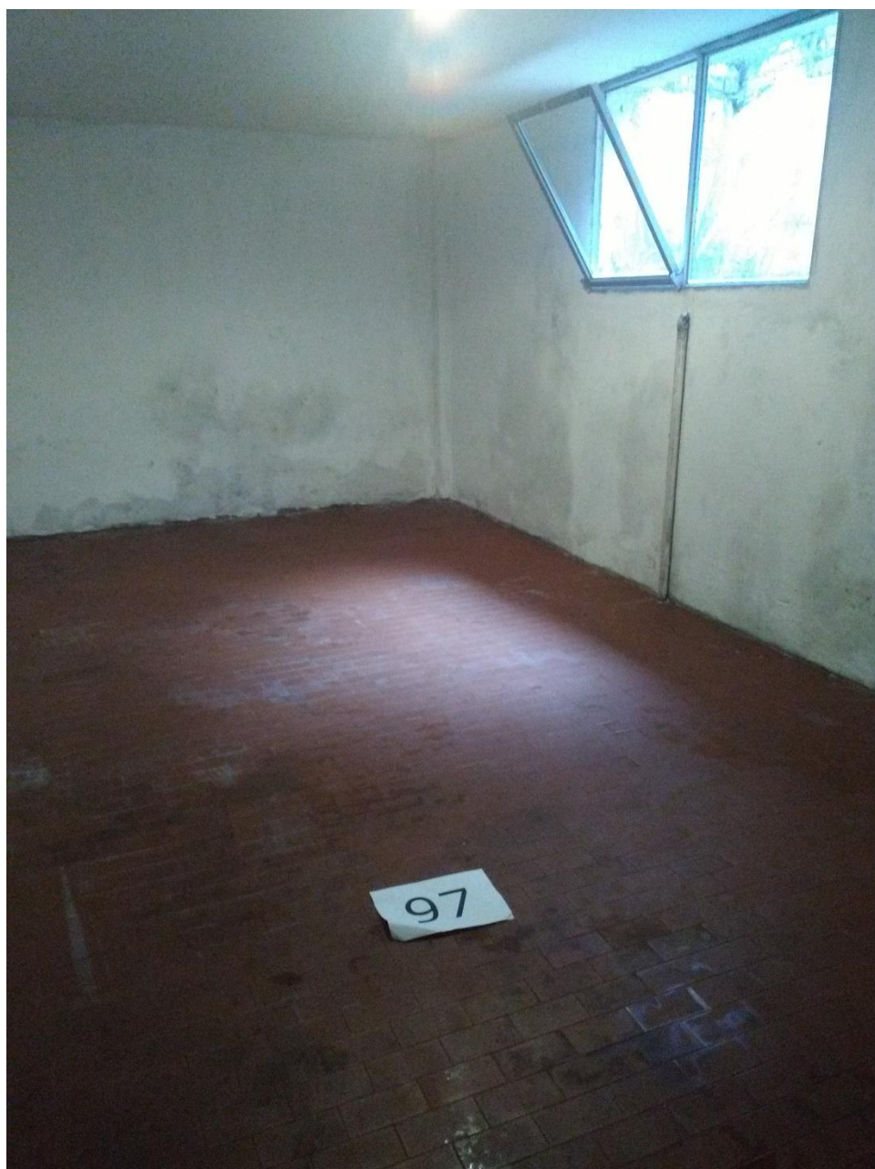
Magazzino (RO foglio 17 part 153 sub 97)
