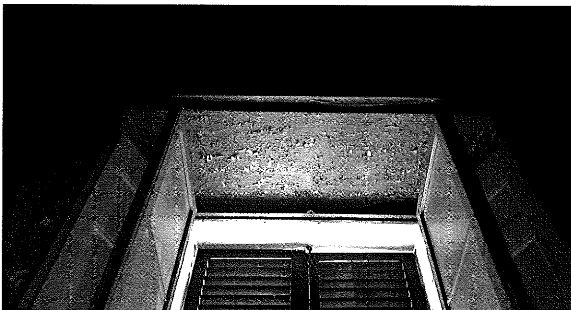
Foto 1. Unità immobiliare interno 2: dettaglio dell'imbotte della finestra con fenomeni di degrado dovuti a infiltrazioni d'acqua
