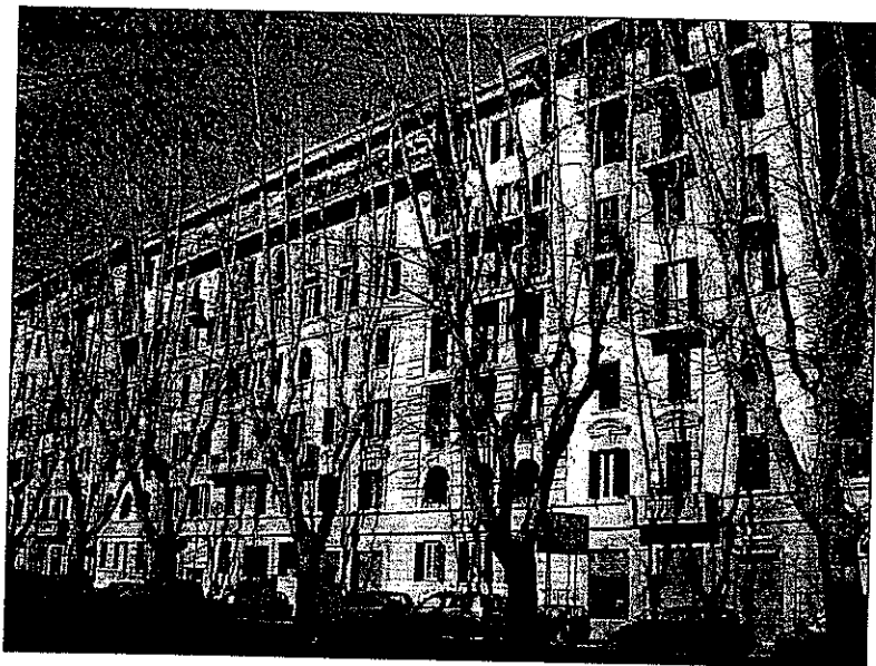
Foto 6: Prospetto dell'edificio su viale delle Milizie.
