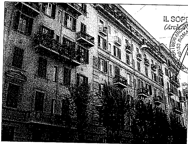
Foto 7: Prospetto dell'edificio su via Silvio Pellico.
