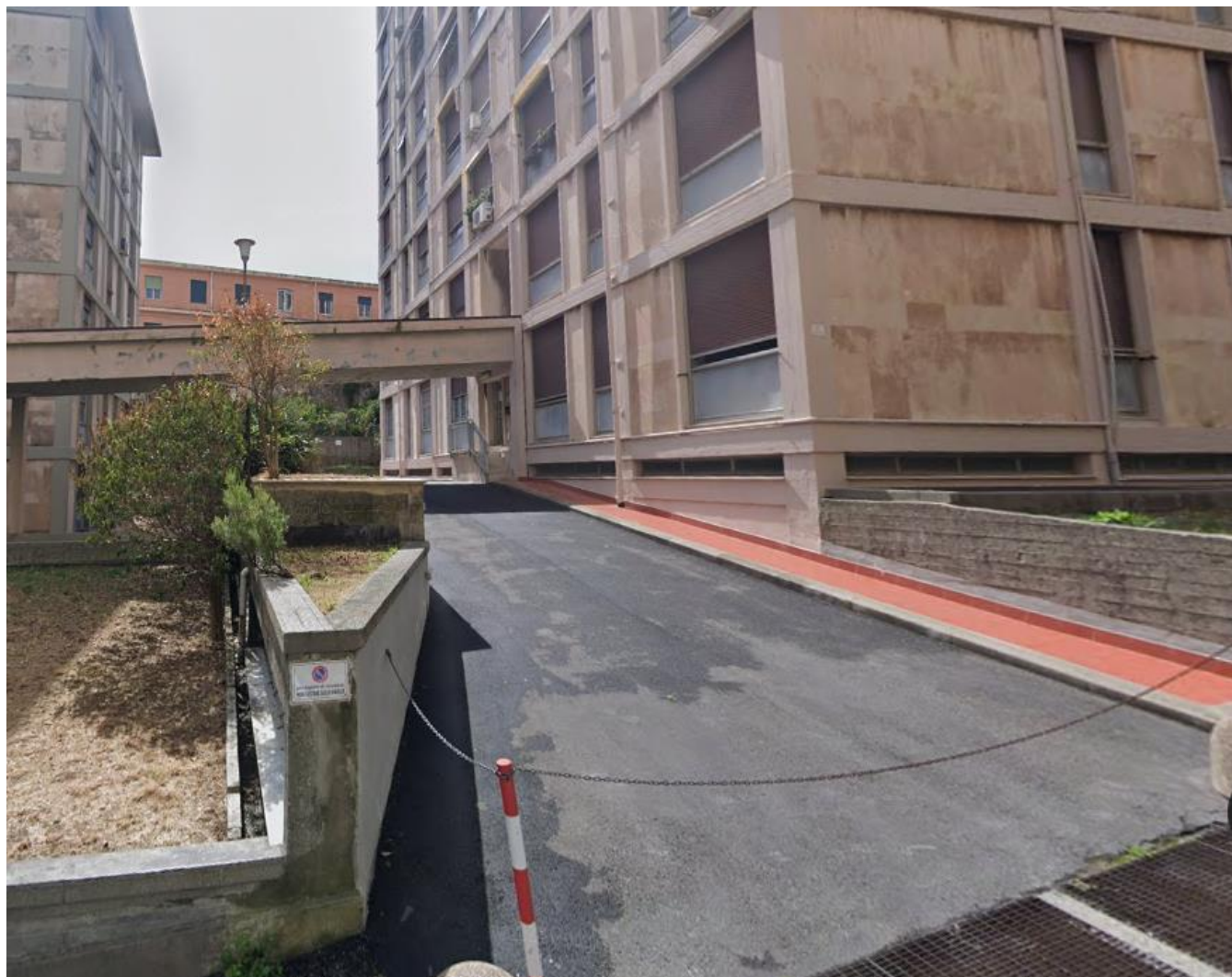
Rampa di accesso a Posti auto scoperti
