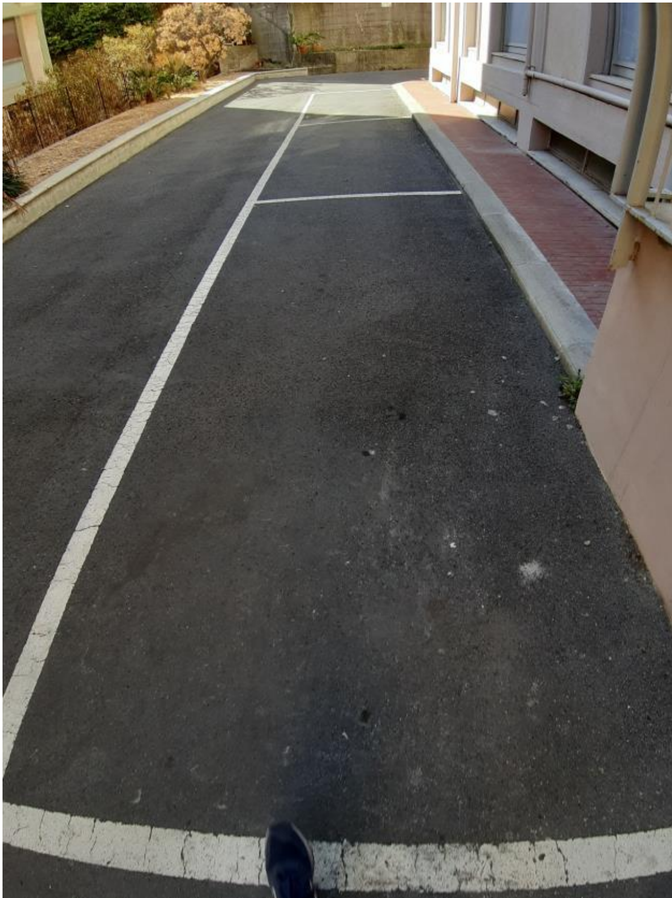
Posti auto scoperti numeri 1, 2, 3 (vista da rampa di accesso)
