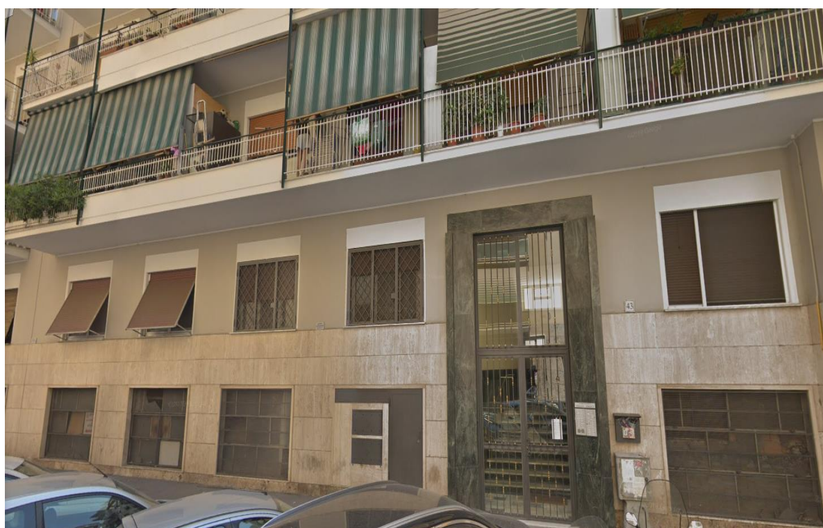
PARTICOLARE INGRESSO EDIFICIO VIA ASINARI S. MARZANO 43
