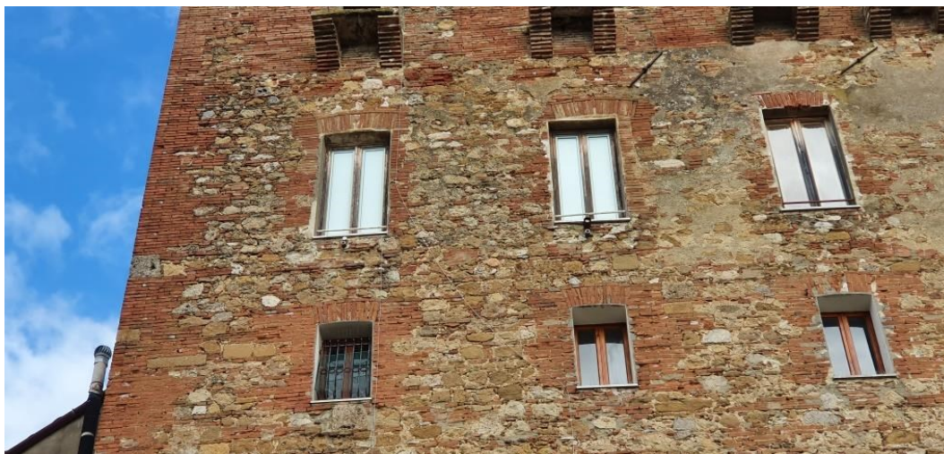
Veduta esterna dell'unità immobiliare, da Via Casini
