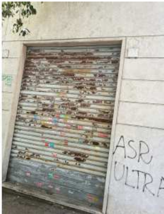
VEDUTA ESTERNA BU 043Y03 – VIA CASALE STROZZI, 25, ROMA – F. 398 – PARTIC. 296 – SUB 3
