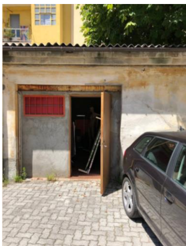
LOCALE INTERNO CORTILE BU 094116
