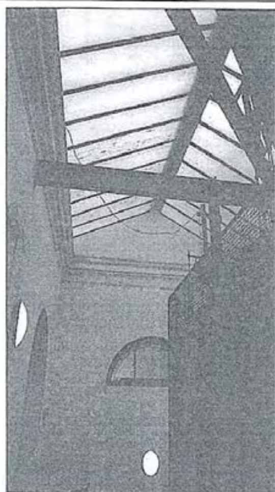
Copertura corpo scala Via Toscana 12
