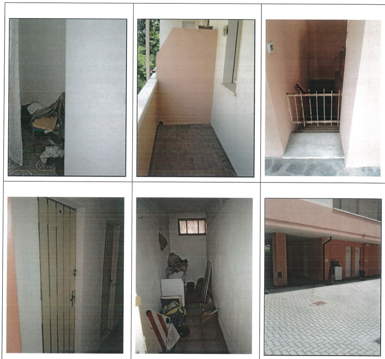
Foto relative al sopralluogo del 22/07/2019
