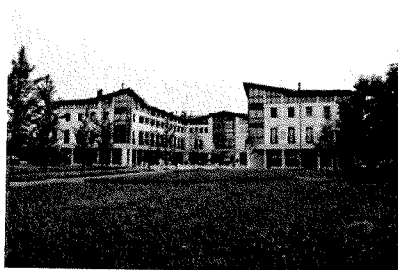
Edificio A in Piazza Dondi Dall'Orologio, Abano Terme (Pd)
