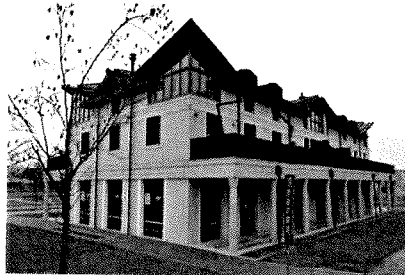
Edificio C in via A. Vespucci, Abano Terme (Pd)
